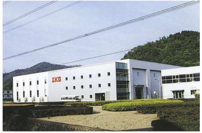
Производственная площадка в Гифу № 2
